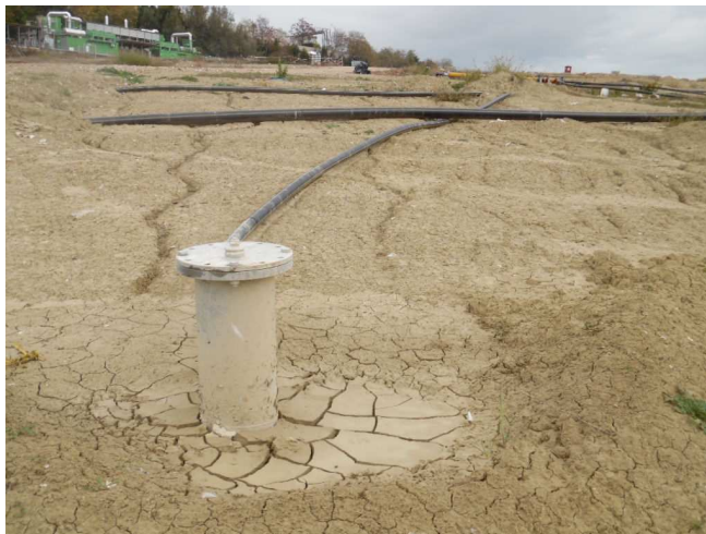
Pozzo di captazione di biogas esistente
