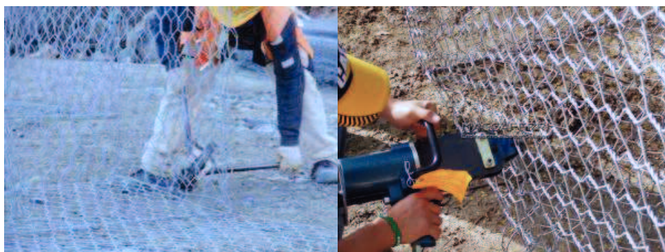
Figura 3 –utilizzo della graffatrice pneumatica (a destra) e manuale (a sinistra)
